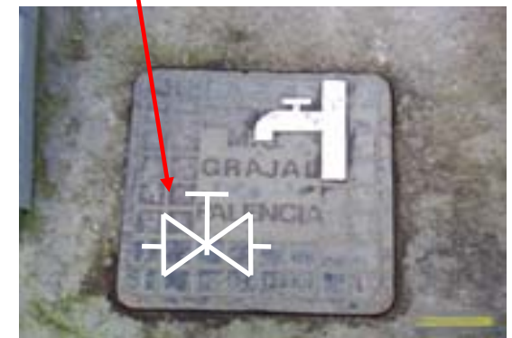
Corte de agua en llaves de paso al grifo
